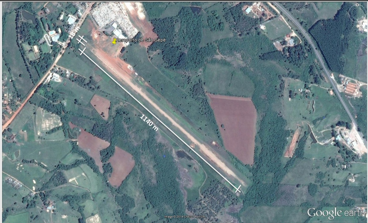
Aeródromo de São Sepé (SSEP) – Fonte: Google Earth
