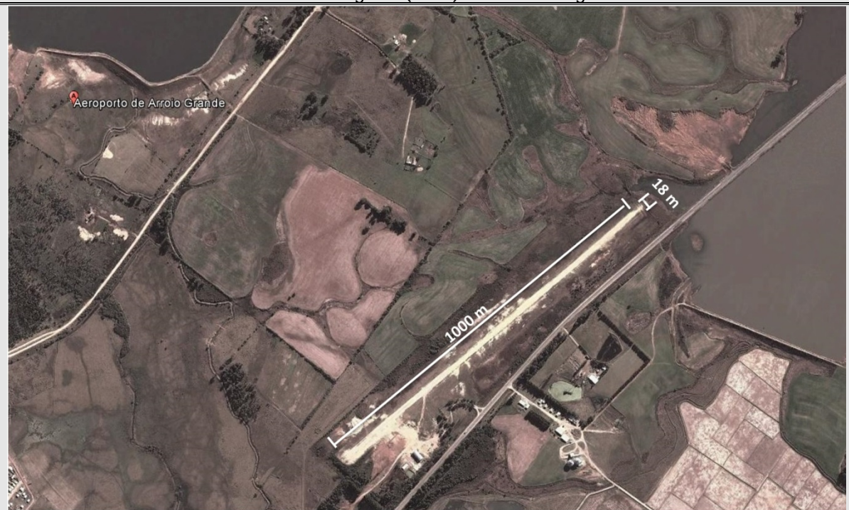
Aeródromo de Arroio Grande (SSAE) – Fonte: Google Earth
