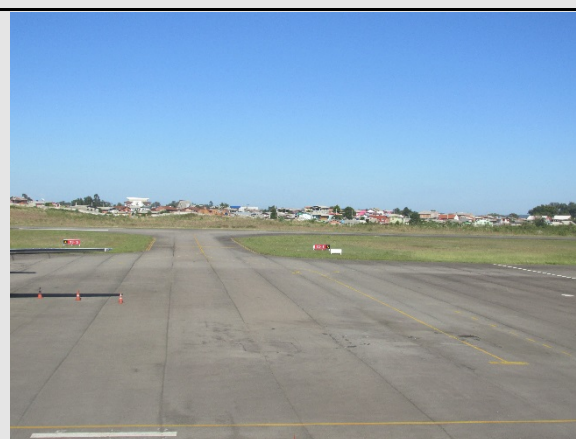
Fotografia 12: Vista da Pista de Pouso/Decolagem Aeroporto – Abril/2014.
