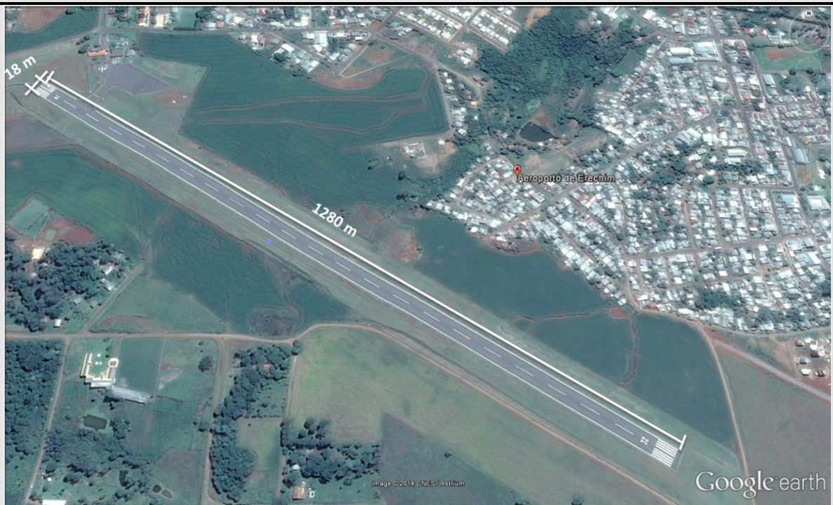
Aeródromo de Erechim (SSER) – Fonte: Google Earth
