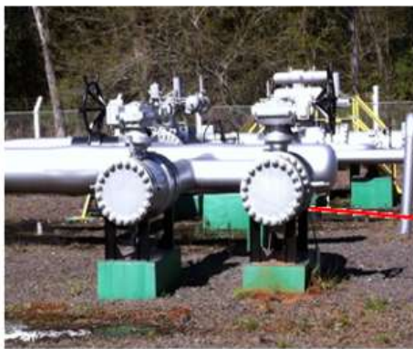
Flange para interligação com Gasoduto Rio Grande – Triunfo (detalhe)
