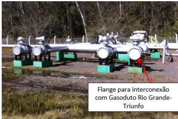
GASUP – Trecho 3: Flanges disponíveis para interligação com Gasoduto Rio Grande - Triunfo
