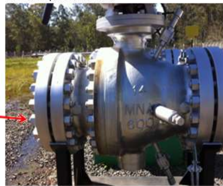
Flange para interligação com Gasoduto Rio Grande – Triunfo (detalhe)
